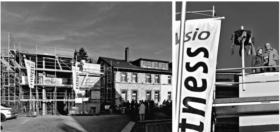
Impressionen vom Richtfest: Der Rohbau und das Ehepaar Müller mit der Richtkrone
