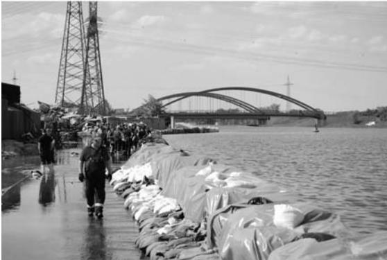
Neben dem Einsatz von Pumpen wurde auch der Ausbau eines Deiches fortgeführt. Mit langen Menschenketten wurden Sandsäcke zu den Deichen gebracht und dort eingesetzt. Mit der Unterstützung von anderen Hilfsorganisationen, der Magdeburger Bevölkerung und dem zügigen Stapeln und Anrichten von Sandsäcken konnte die gefährliche Situation entspannt werden.
